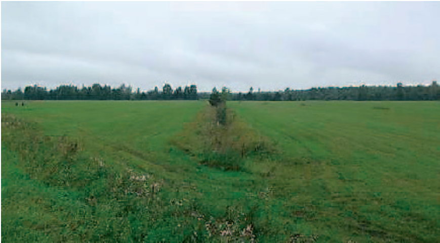
Рис. 6.3. Мелиоративные каналы на осушенных лугах между деревнями Богословка и Красноярка Зырянского района (фото Т.Н. Жилиной, 2011)
