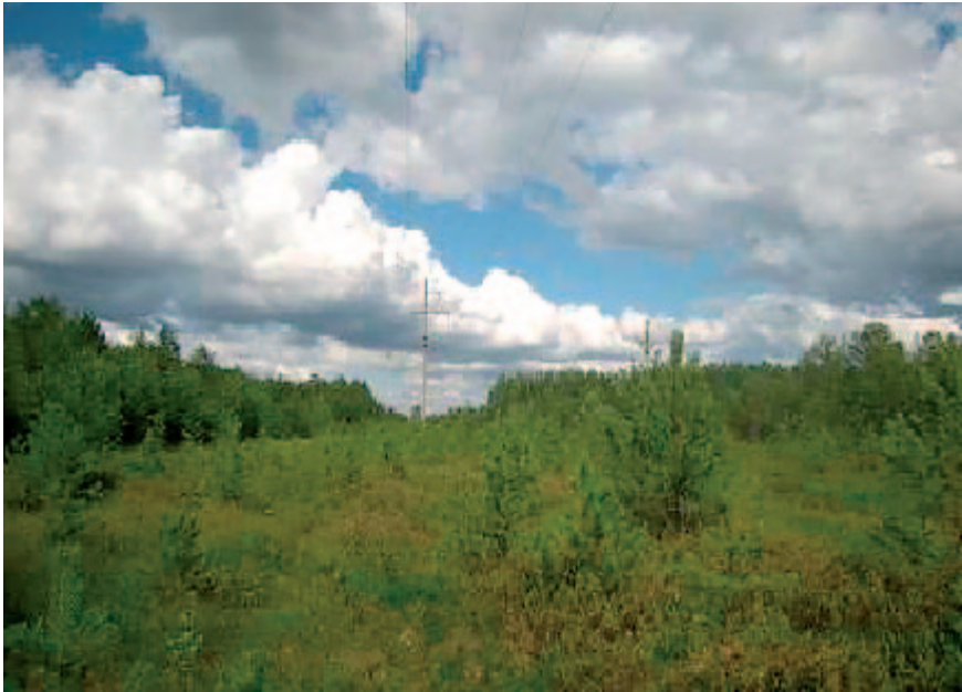
Рис. 7.2. Пересечение болота ЛЭП (фото Ю.А. Харанжевской, 2011)
