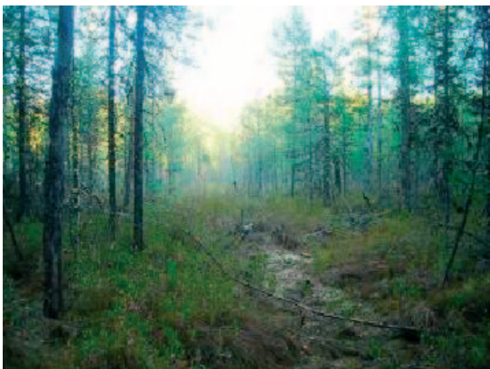
Рис. 6.14. Вырубка под строящуюся ЛЭП (фото З.Н. Квасниковой, 2011)
